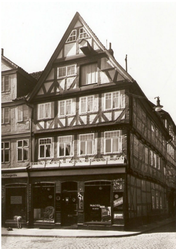
Bild 1: Die giebelständige Marktfassade des Fachwerkgebäudes Am Markt 5, erbaut im 17. Jahrhundert mit Blick in die Rosenthaler Straße, Zustand vermutlich um 1933. Die Baumaßnahme umfasst die Instandsetzung der Giebel- und der Trauffassade.
