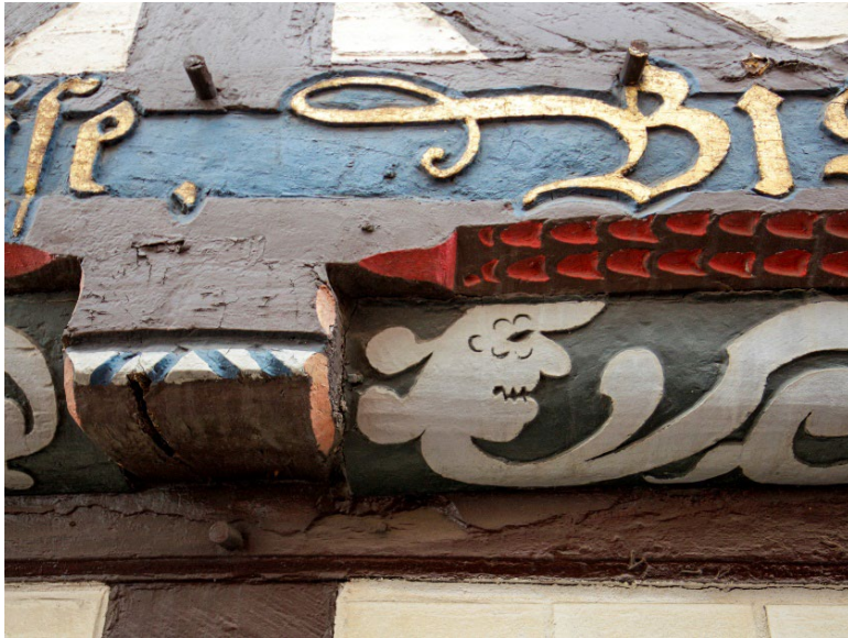
Bild 8: Detailaufnahme des geschnitzten Spruchbandes, den verzierten Füllhölzern und der Deckenbalken. Priorität hat der Erhalt der geschnitzten Hölzer, auch wenn diese Schädigungen aufweisen.
