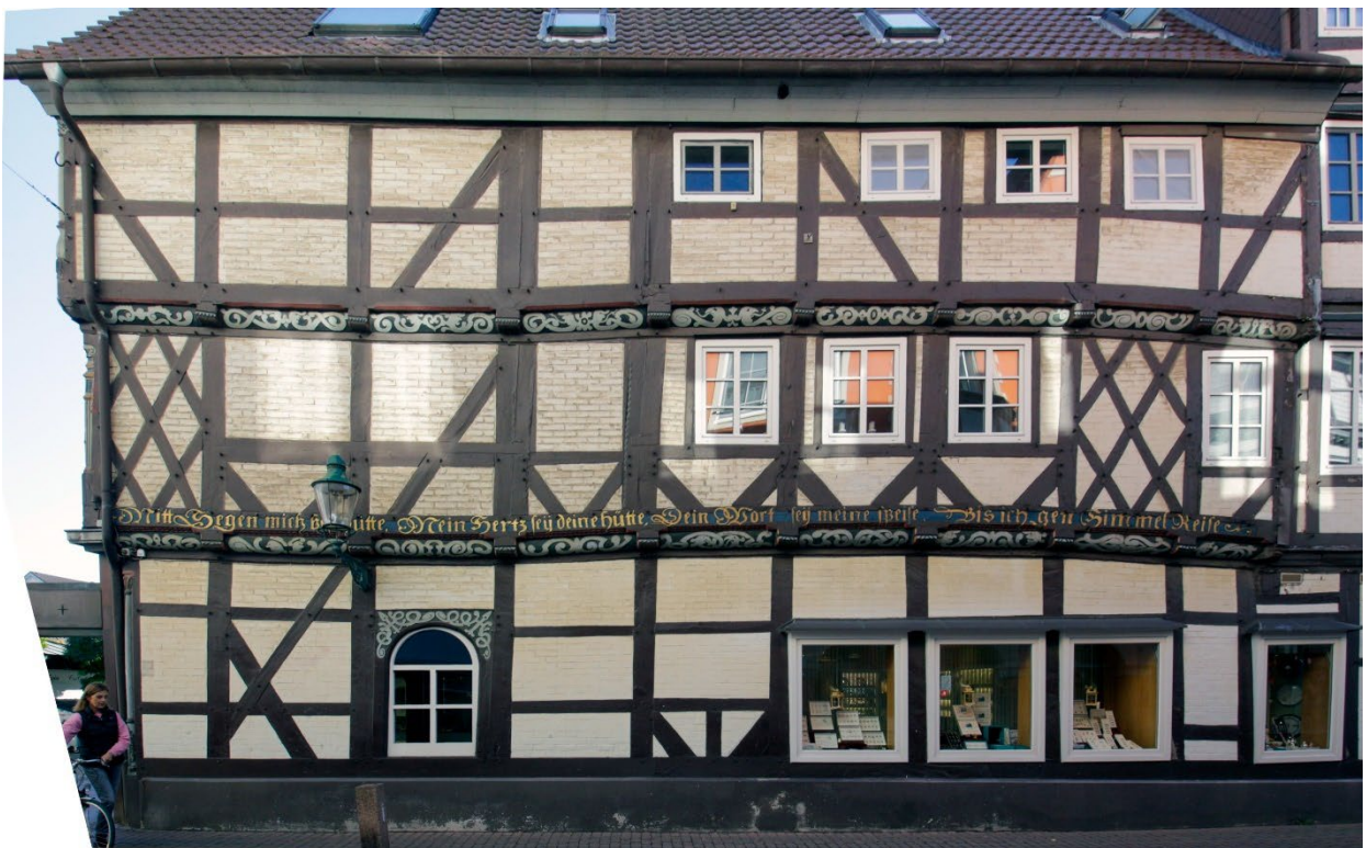
Bild 5: Blick auf die Trauffassade in der Rosenthaler Straße. Die Fassade war ursprünglich die nachrangige Schmuckfassade. Im Gegensatz zur Fassade am Markt blieb hier das Schnitzwerk weitgehend erhalten. Auffällig sind die enormen Verformungen in der Deckenebene, ablesbar an den Schwellen der Obergeschosse. Durch den Einbau einer betonierten Kellerdecke, Kelleraußenwände und der betonierten Sockelaufkantung unter der Erdgeschossschwelle sind keine Verformungen mehr zu erwarten.
